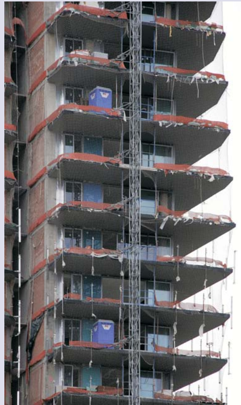
Edificio en obras
